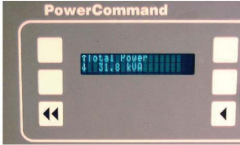
PCC2100带有一个数码显示屏，显示屏由两行组成，每行20个字符。显示屏两边有6个覆膜触摸按键，通过这些键可进入调整菜单从而对控制进行调整。（在控制盘中没有旋转电位器，所有控制调整是通过控制盘面的按键输入或InPower服务软件完成的。）屏幕显示可编程为多种语言，显示也可设定计量单位。
